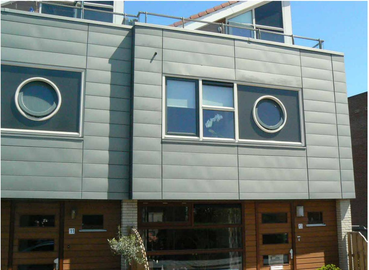
Gestalterisch bieten sich die Möglichkeiten einer horizontalen, vertikalen und diagonalen Ausrichtung der max. 4,00 m langen Paneele. Des Weiteren kann die Fuge, die auch Schattenfuge genannt wird, zwischen 2-30 mm variabel ausgebildet werden.
