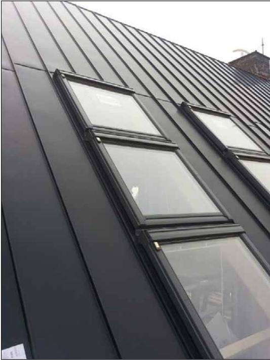
Für den Anschluss von Dachwohnraumfenstern in die Dacheindeckung stehen sowohl die falztechnisch handwerklichen Varianten als auch vorgefertigte, steckbare Anschlussrahmen der Fensterhersteller zur Verfügung. Welche Form der Einbindung gewählt wird, muss auftragsbezogen entschieden werden.
