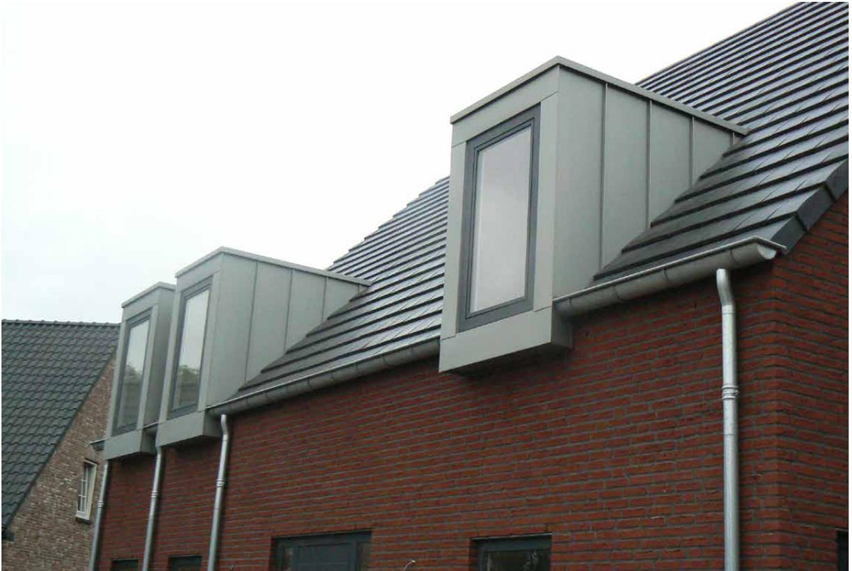
Die Eindeckung und Bekleidung von Gauben kann mit den üblichen Klempnertechniken in Winkel- oder Doppelstehfalztechnik, sowie Rauten, Paneele und weitere Fassadensysteme ausgeführt werden. Es gibt verschiedene Ausführungen und Formen sowie Satteldachgauben, Spitzgauben und Rundgauben.
