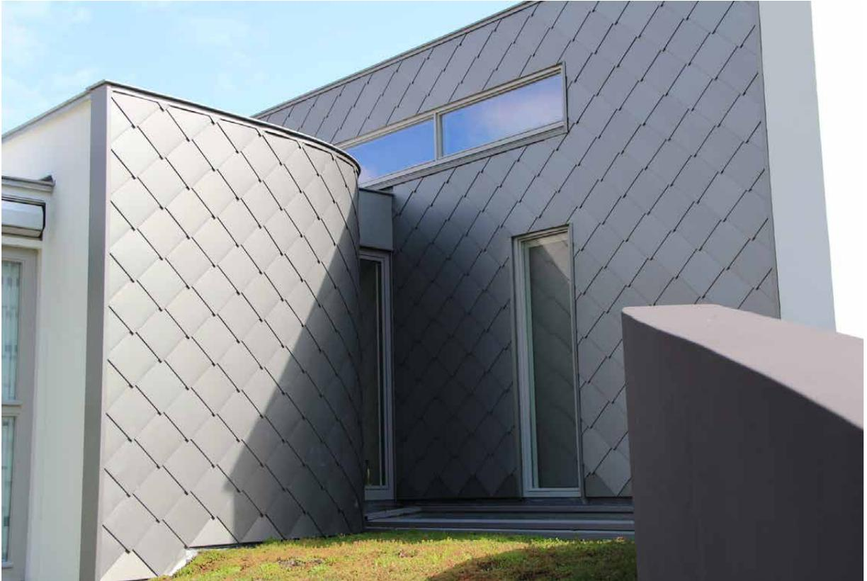
Das (Standard) Rautensystem besteht aus kleinen gleichgestalteten, gekanteten Blechteilen, die ineinander gehakt werden. Die am meisten verwendete Form einer Raute ist das Quadrat, während auch die Rhombenform regelmäßig vorkommt. In diesem Ratgeber wird die quadratische Raute besprochen. Das Decken und Bekleiden leicht gebogener Flächen lässt sich mit Rauten gut ausführen. Die eingehakten Rauten bilden ein Mosaik aus gleichgeformten Flächen mit vertikal und horizontal verlaufenden Diagonalen.
