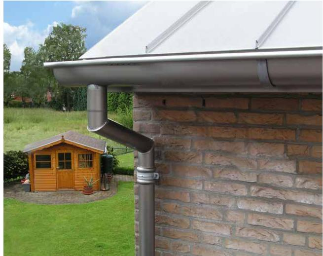
Für die sichere Ableitung des Niederschlagswassers von Dächern und Balkonen ist die Querschnittsfläche der Regenfallleitung von entscheidender Bedeutung. Der erforderlichen Regenfallleitung wird dann die entsprechende Dachrinne (Form und Maße) inkl. Rinneneinlaufstutzen und Bögen zugeordnet. Im Dachentwässerungsbereich wird zwischen außen- und innenliegenden Dachrinnen unterschieden. Weitere Unterscheidungsmerkmale sind:
