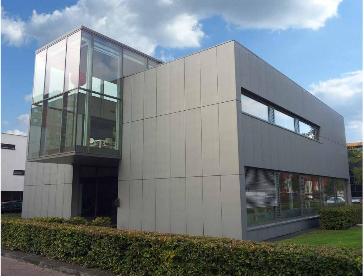
NOVA COMPOSITE kann mit handelsüblichen Maschinen und Werkzeugen verarbeitet und zugeschnitten, als Kassette angefertigt oder einfach als Platte verschraubt, genietet oder geklemmt werden. Die enorme Festigkeit wird durch die Plattendicke von insgesamt 4 mm erreicht. Das Titanzink an der Ober- und Unterseite hat eine Dicke von jeweils 0,50 mm und der Polyethylen LD-PE Kern von 3 mm.
