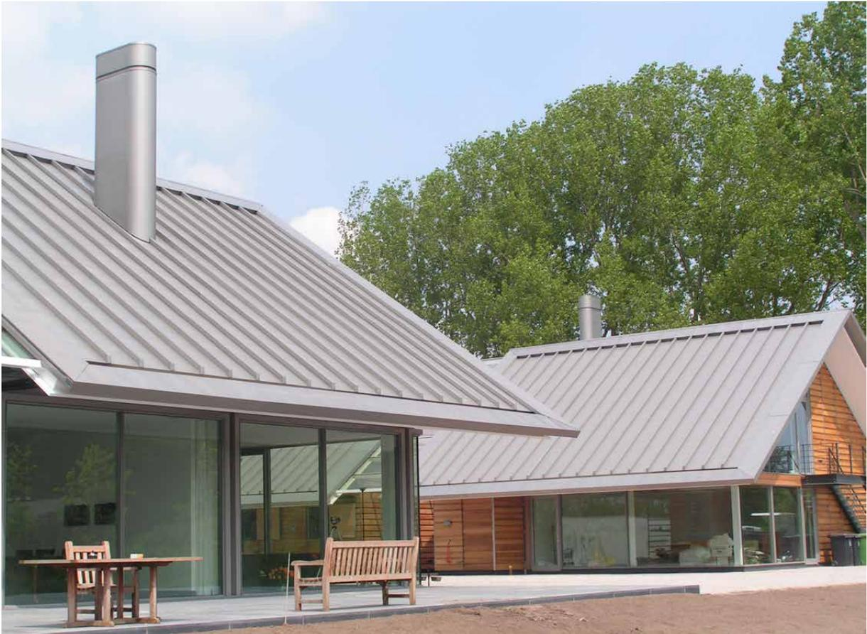
Ein Leistendach ist eine Dacheindeckung, die aus Zinkscharen besteht, die in Längsrichtung mit Aufkantungen versehen sind. Zwischen den Scharen werden sogenannte Holzleisten auf der Holzschalung montiert. Diese Holzleisten haben einen trapezförmigen Querschnitt mit einer Breite von 40-50 mm und einer Höhe von 60 mm. Der wasserdichte Abschluss zwischen Dachscharen und Holzleisten wird durch eine Standard Leistenkappe erreicht.
