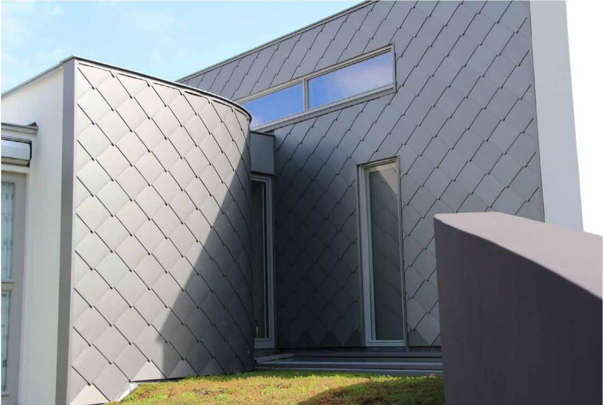
Rauten bieten eine gute Lösung für die Bekleidung von mäßig gekrümmten Flächen. Ineinander gehakt bilden die Rauten ein Mosaik aus gleichmäßigen Flächen mit senkrechten und waagerechten Diagonalen.
