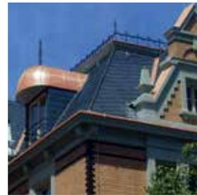
ganz bewusst, damit das Material auch mit seiner "walzblanken", rotgoldglänzenden Kupferoberfläche zum Einsatz kommt. Bei Bewitterung nach Montage wird diese Schicht dann abgetragen und das Material bildet die Patina aus. Dieser Prozess erfolgt je nach Einbaurichtung und – neigung unterschiedlich schnell und gleichmäßig. Eine stabile, gleichmäßige Optik wird daher im Verlaufe von wenigen Wochen bis zu einem Jahr erreicht.
