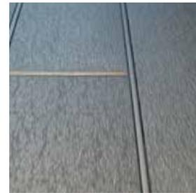
Es findet keine Beschichtung oder Lackierung statt. Die zinktypischen Eigenschaften der Oberfläche bleiben vollständig erhalten. Zusätzlich wird eine dünne, temporäre Schutzschicht aufgebracht, welche die Optik bis zur Fertigstellung der Montage vor leichten Verschmutzungen wie z.B. Fingerabdrücken schützt. Bei natürlicher Bewitterung nach Montage wird diese Schutzschicht mit der Zeit abgetragen.
